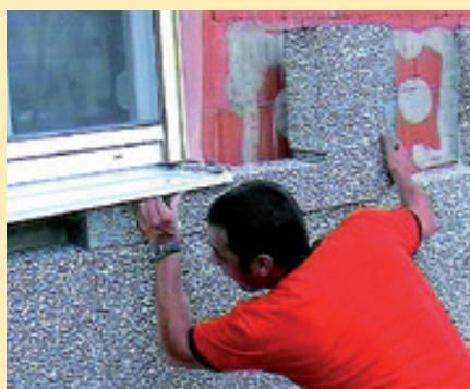
Na pukotine ili fuge ispod 5 mm (panelna gradnja, skeletna gradnja) ne smije se pozicionirati spojeve ploča. Ovdje treba voditi računa da preklop bude 10 cm. Spojevi izolacijskih ploča ne smiju prelaziti u rubove zidnih otvora, kako bi se u najvećoj mjeri sprječilo njihovo pucanje. Svakako se na temelju dugogodišnjeg pozitivnog iskustva preporučuje izrez pod pravim kutem.
