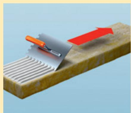
Lijepljenje jednostrano premazanih lamele mora se također obaviti po cijeloj površini. Najprije masu za lijepljenje treba tanko izvući pod pritiskom i zatim nanijeti ravnomjerni sloj ljepila, koju valja pročešljati nazubljenom lopaticom 10x10 mm. Lijepljenje se vrši tako da nepremazana površina ploče ostane vidljiva za nanošenje završnog premaza.
