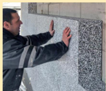
Kod prvog reda na podnožnoj šini treba paziti da ploče čvrsto naliježu na prednji rub šine. Ni u kojem slučaju šina ne smije probijati van zbog toga što nije nanešeno dovoljno ljepila. Donji završetak izolacijske ploče treba izvesti tako da traka ljepila prolazi po njemu bez prekida (zaštita od kukaca, glodavaca, širenja požara), čime se u najvećoj mjeri spriječava dovod zraka odozdo, iza razine izolacijske ploče.
