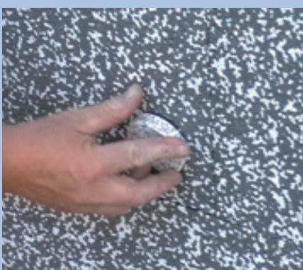
Oprema koja je pritom potrebna sastoji se od univerzalne pričvršnice Capatect Universaldübel Rondelle 2G i pripadajućeg alata Capatect 2G-Montagetool.
