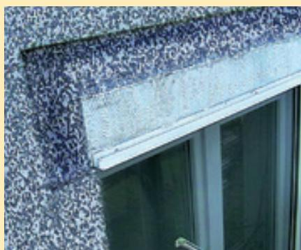
Isturene dijelove, poput npr. kutija za rolete, treba premostiti bez spoja ploča. Suvišna izolacija smije se pritom izrezati sa stražnje strane izolacijskih ploča tako da preostala deblijina iznosi najmanje 3 cm.
