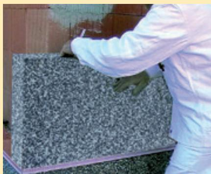
Za postizanje preciznih vanjskih kuteva treba najprije jednu izolacijsku ploču oblijepiti uz odgovarajući neiskorišteni dio, a drugu ploču spojiti s njom. Neiskorištenu traku treba precizno odrezati. Kutno lijepljenje mora se obaviti naizmjenično, kako bi se postiglo ozubljenje. Kod unutarnjih kuteva može se izostaviti ozubljenje. Kod debljina ploča od 20 cm nadalje preporučujemo lijepljenje spojnih bridova sa PU-Montagekleber po čitavoj površini.
