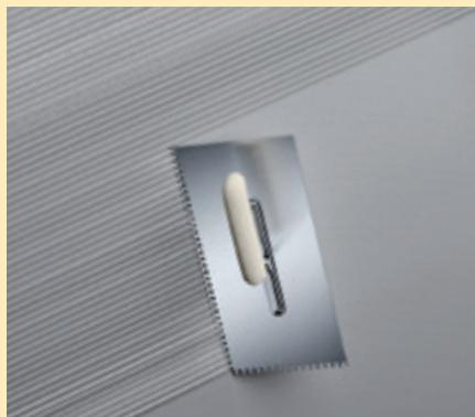
Prije nanošenja MK-Kraftputz potrebno je površinu obrađenu sa Capatect Haftmörtel grob pročešljati nazubljenom lopaticom sa zupcima od 4 mm.
