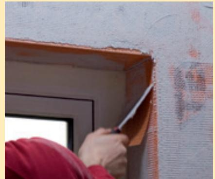
Kod izolacijskih ploča od mineralne vune (ploče i lamele), od izolacijskog pluta i od konopljinih vlakana treba prije nanošenja armirnog sloja izraditi izravnavaajući sloj od Capatect Haftmörtel fein/grob ili Minera Carbon.
