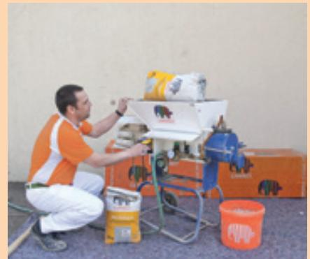
Odabranu strukturu žbuku treba navući po čitavoj površini, zatim razvući na zrnatost i – već prema tipu žbuke – strukturirati nehrđajućim čeličnim ili plastičnim gletierom.
