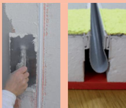
Ako se traži dilatacijska fuga bez prekida, može se primjeniti profil Capatect Dehnfugenprofil E Rolle. Za tu svrhu treba oba osnovna profila s priloženom razmaknicom uložiti u prethodno naneseni armirni sloj. Razmaknicu treba utaknuti naizmjениčno raspoređenu u utor za prihvatanje uložne petlje profila dilatacijske fuge. Ovo služi da se prihvativi utor kao i raspor dilatacijske fuge zaštite od onečišćenja masom za armiranje.
